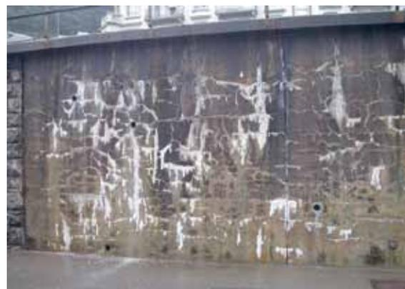
Fig. 2: Dégâts de RAG d'un mur de soutènement
