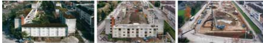
Das Wesen eines Ersatzneubaus. Die rund 40-jährigen Bauten an der Bärenstrasse wurden abgedreht, um Platz für die Neubausiedlung Werdwies herzu.
