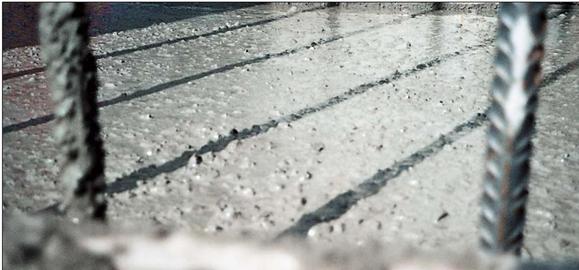
Bei leichtverdichtbaren Betonen handelt es sich um Betone mit einer sehr guten Fließfähigkeit. Leichtverdichtbare Betone benötigen daher einen geringeren Verdichtungsaufwand. Mit einem LVB wird das Einbringen des Frischbetons auf der Baustelle vereinfacht und verkürzt.
